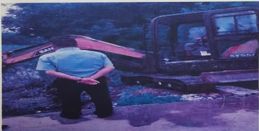
施工照片 天气: 阴 22度 东北风≤3级 湿度92% 经纬度: 112.5017284 地址: 34.6214269 洛阳市洛龙区开元大桥在洛龙区第二初级中学(大屯校区)附近 时间: 2020-06-12 10:11:43
