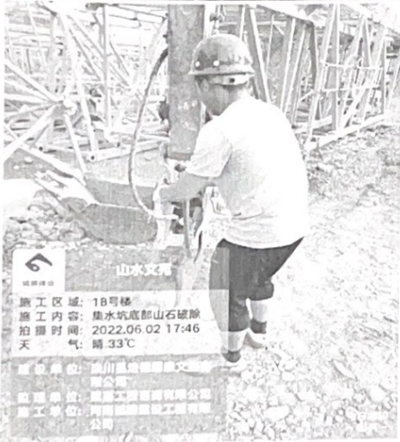
山水文苑 施工区域: 18号楼 施工内容: 集水坑底部山石破除 拍摄时间: 2022.06.01 20:54 天气: 晴 28℃ 建设单位: 四川嘉浩德康文化旅游有限公司 监理单位: 隆基工程咨询有限公司 施工单位: 河南诚鼎建设工程有限公司
