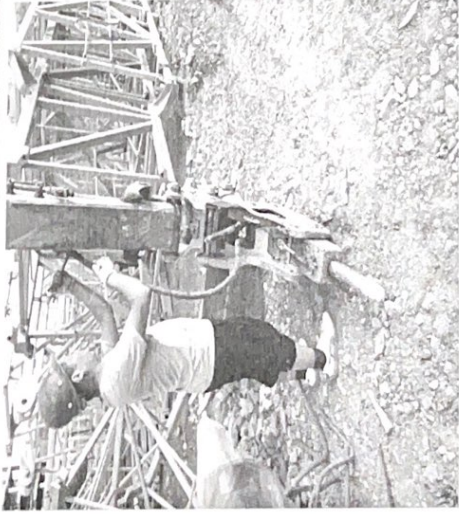
山水文苑 施工区域: 19号楼 施工内容: 集水坑底部山石破除 拍摄时间: 2022.06.01 08:30 天气: 晴 19℃ 建设单位: 四川嘉浩德康文化旅游有限公司 监理单位: 隆基工程咨询有限公司 施工单位: 河南诚鼎建设工程有限公司
