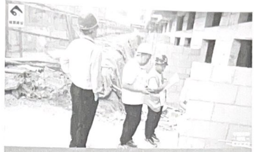
項目：山水文園（廣州） 計畫：999 施工區域：S1-3号楼 施工內容：自一級受剪鋼筋 監督時間：2022.06.11 17:22 天氣：多云 33°C 地點：雲川縣·雲川派出所海濱別墅 監理單位：廣州建信房地產開發有限公司 監工單位：河南建信房地產開發有限公司
