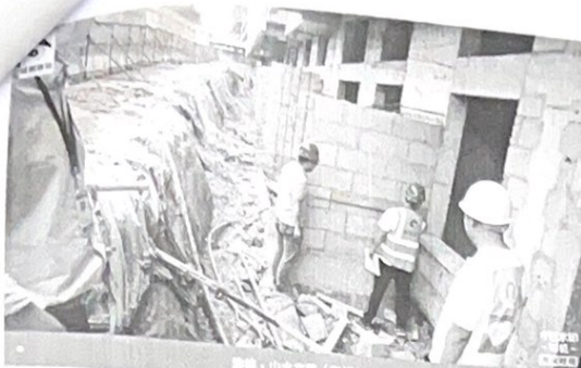
項目：山水文園（廣州） 計畫：1000 施工區域：S1-3号楼 施工內容：自一級受剪鋼筋 監督時間：2022.06.11 17:23 天氣：多云 33°C 地點：雲川縣·雲川派出所海濱別墅 監理單位：廣州建信房地產開發有限公司 監工單位：河南建信房地產開發有限公司
