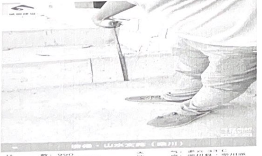
項目：山水文園（廣州） 計畫：993 施工區域：S1-3号楼 施工內容：自一級受剪鋼筋 監督時間：2022.06.11 17:18 天氣：多云 33°C 地點：雲川縣·雲川派出所海濱別墅 監理單位：廣州建信房地產開發有限公司 監工單位：河南建信房地產開發有限公司
