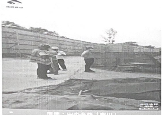
項目：山水文園（廣州） 計畫：1000 施工區域：S1-3号楼 施工內容：自一級受剪鋼筋 監督時間：2022.06.11 17:23 天氣：多云 33°C 地點：雲川縣·雲川派出所海濱別墅 監理單位：廣州建信房地產開發有限公司 監工單位：河南建信房地產開發有限公司
