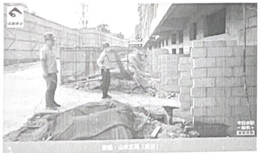
項目：山水文園（廣州） 計畫：993 施工區域：S1-3号楼 施工內容：自一級受剪鋼筋 監督時間：2022.06.11 17:18 天氣：多云 33°C 地點：雲川縣·雲川派出所海濱別墅 監理單位：廣州建信房地產開發有限公司 監工單位：河南建信房地產開發有限公司
