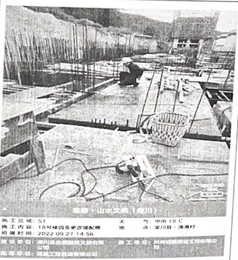
洛魏·山水文苑（濮阳） 施工区域: S1 施工内容: 18号楼内变更改墙配模 天气: 多云 28℃ 拍摄时间: 2022.09.28 14:04 地点: 梁川县·魏州大道 建设单位: 濮阳威朋建设发展有限公司 监理单位: 威朋工程咨询有限公司 施工单位: 河南威朋建设工程有限公司
