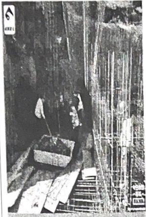
施工区域 S1-19#楼A区 天气 晴 11°C 拍摄时间 2022.10.12.09:06 地点 贵州·贵阳·清镇市 监理单位: 贵州中远建设监理有限公司 建设单位: 贵州中远建设集团
