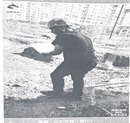
计 划 数: 1083 施 工 区 域: S1-东大门 施 工 内 容: 土方收方 拍 摄 时 间: 2022.08.18 天 气: 多云 29℃ 地 点: 梁川县·O08乡道
