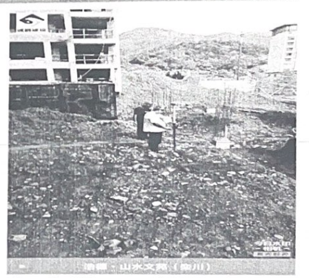
计 划 数: 1084 施 工 区 域: S1-东大门 施 工 内 容: 土方收方 拍 摄 时 间: 2022.08.18 天 气: 多云 29℃ 地 点: 梁川县·O08乡道
