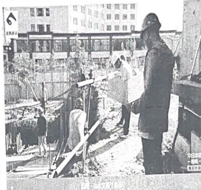
1060 拍摄时间: 2022.08.14 08:47 施工区域: S1-东大门 施工内容: 土方收方 天气: 多云 气温: 30°C 地点: 崇川区·008号
