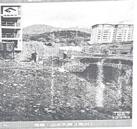
计 划 数: 1077 施 工 区 域: S1-东大门 施 工 内 容: 土方收方 拍 摄 时 间: 2022.08.18 天 气: 多云 29℃ 地 点: 梁川县·梁川派出所清溪警务室
