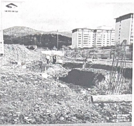
计 划 数: 1078 施 工 区 域: S1-东大门 施 工 内 容: 土方收方 拍 摄 时 间: 2022.08.18 天 气: 多云 29℃ 地 点: 梁川县·梁川派出所清溪警务室
