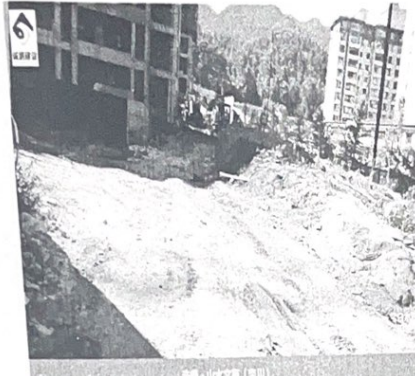
1056 拍摄时间: 2022.07.08 15:48 施工区域: S1-东大门 施工内容: 土方开挖 天气: 晴 气温: 35°C 地点: 崇川区·008号
