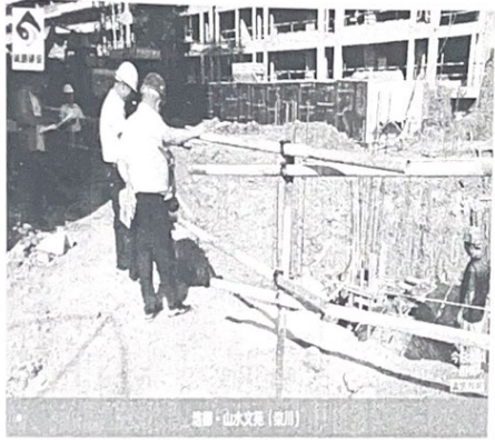
计 数: 1061 施工区域: S1-东大门 施工内容: 土方收方 拍摄时间: 2022.08.14 08:48 天气: 多云 30°C 地点: 崇川区·008乡道
