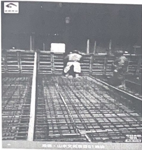
黑桥·山水文苑项目S1地梁
