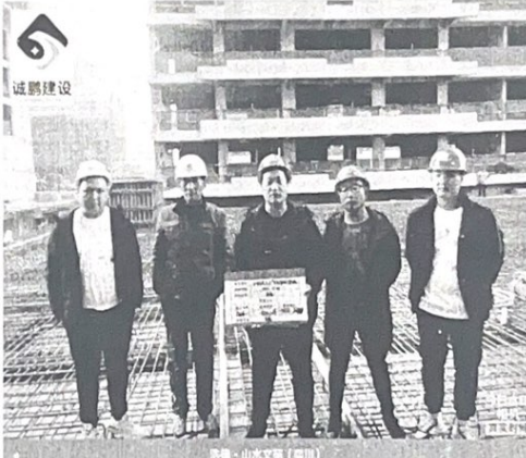
浩德·山水文苑（濮阳） 施工区域：S1-5#-9# 天气：晴 18℃ 施工内容：墙柱顶板验收 地点：濮阳市梁川县·梁川派出所西湾警务室 拍摄时间：2021.11.24 17:36 建设单位：濮川浩德建筑设计有限公司 施工单位：河南诚德建设工程有限公司 监理单位：建德工程咨询有限公司
