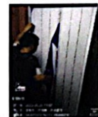
5.23 1-5#电梯广告安装视频 (100)
