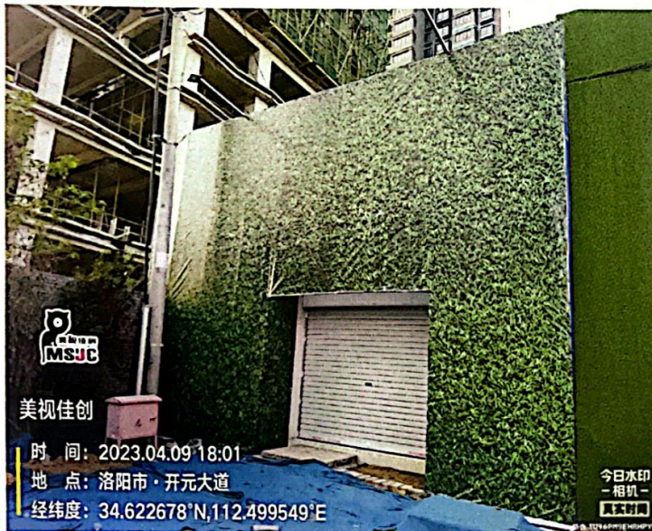
6期地块围挡喷绘加厚喷绘布打孔穿绳6x8.4米1块50.4m 2
