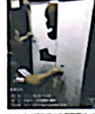
5.23 1-5#电梯广告安装视频 (65)
