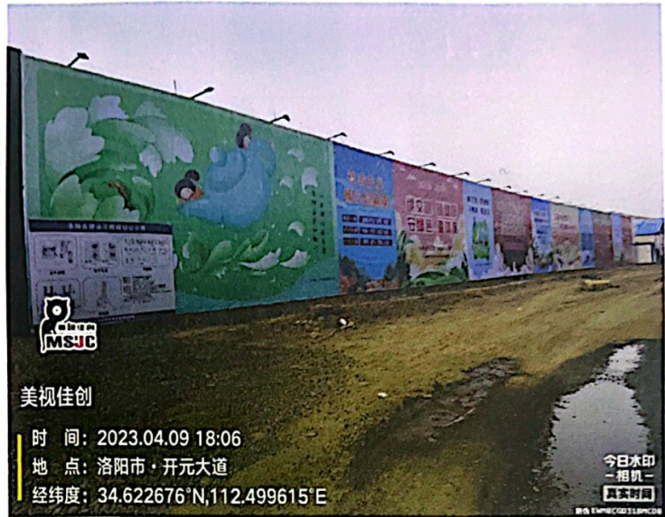
6期地块围挡喷绘加厚喷绘布打孔穿绳 6x98米 1块 588m 2
