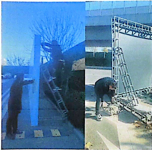
9、2024年8月26日, 吊车装龙门架 PVC板一台班, PVC板 8.5 m²。
