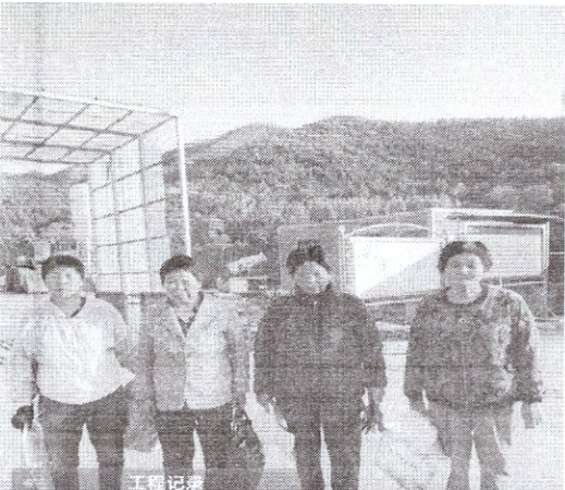
工程记录 施工内容: S7地块, 下沉庭院垃圾 清理 拍摄时间: 2025.05.05 07:14 地点: 我在这里
