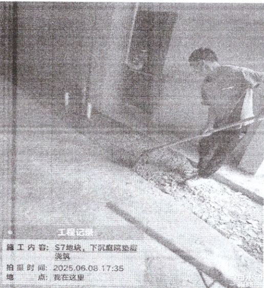
工程记录 施工内容: S7地块, 下沉庭院垫层浇筑 拍摄时间: 2025.06.08 16:37 地点: 在这里
